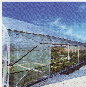
Seitliche Rohrwickellüftung mit Windschutznetz.
