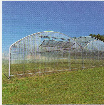
Dachlüftung und Giebelklappenlüftung.
