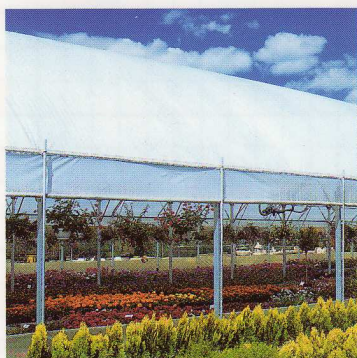
Seitliche Rohrwickellüftung mit Windsicherungsbügel.
