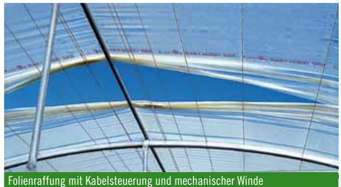
Folienraffung mit Kabelsteuerung und mechanischer Winde
