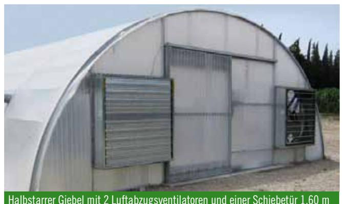
Halbstarre Giebel mit 2 Luftabzugsventilatoren und einer Schiebetür 1,60 m
