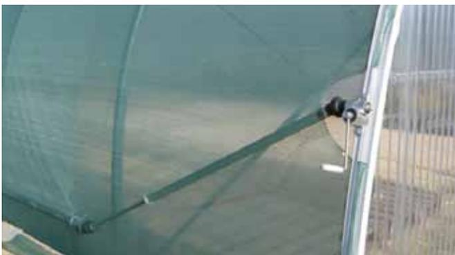
Durchgehende Seitenlüftung durch Folienaufrollung (optional Teleskopstil und Motorisierung)
